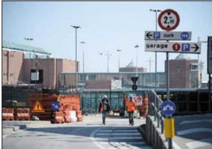
CANTIERI APERTI Lavori in corso per ingrandire l'aeroporto
